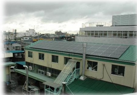
太陽光発電の設置
