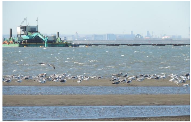
カモメ類の群れと浚渫工事の様子 (10/8)
