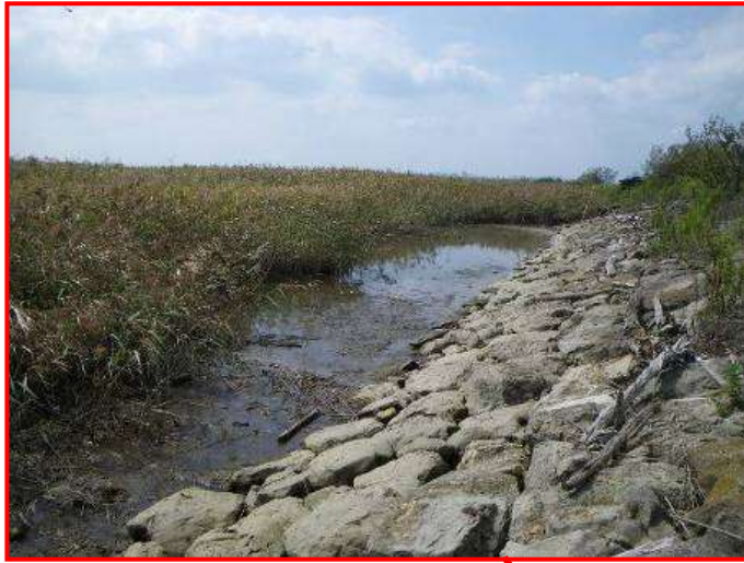
St. T4 東なぎさ(北側)
